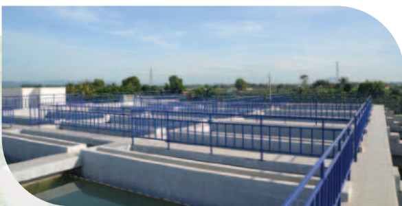
Nhà máy cấp nước / 7500 m 3 / ngày đêm
